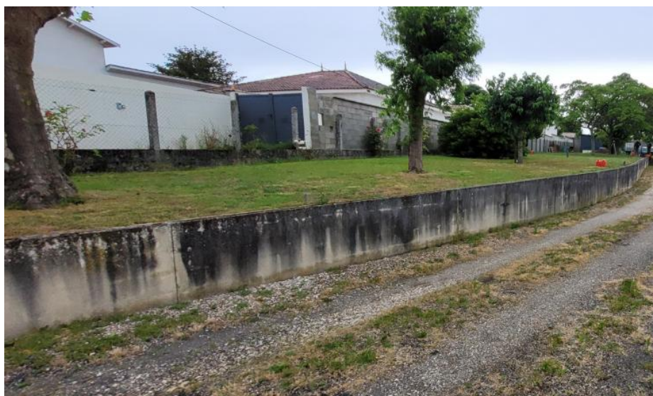
Figure 4 : Muret de soutènement actuellement présent sur la zone d'étude
